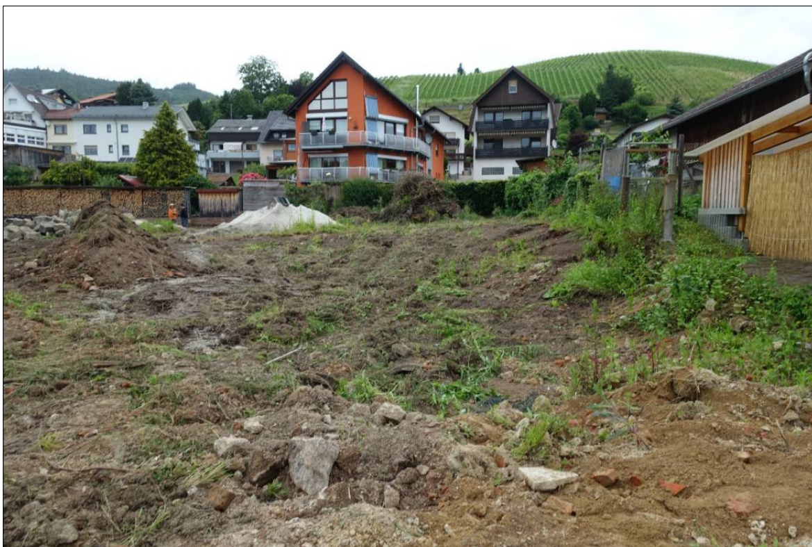
Abbildung 4: Blick von Süden entlang der westlichen Grenze des Baugrundstücks (Aufnahme vom 29.05.2024)
